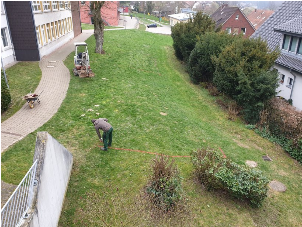
Vor dem ersten Spatenstich: Gartenbauingenieur Simon Jasmer markiert die Gartenfläche. Foto: Stefan Schubert
